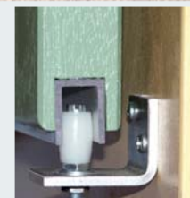
Guidage bas, olive sur équerre (volet bois)
