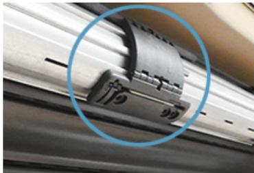
Des verrous automatiques sont fixés sur le tube d'enroulement du volet. Lorsque le volet est fermé, ces verrous empêchent son ouverture par soulèvement. Chez Volets sur Mesure, chaque volet roulant est équipé de ce système anti-relevage du tablier contribuant au retard à l'effraction.
